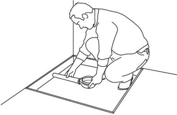
1) Positionner et centrer le siphon dans la réservation et le raccorder selon les règles de l'art à la conduite d'évacuation DN 50 prévue.
