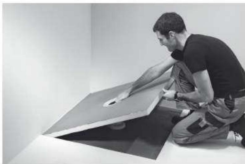
Placez fermement le receveur sur le mortier en s'assurant de sa bonne mise en place par rapport au siphon (le siphon doit être au centre du joint).
