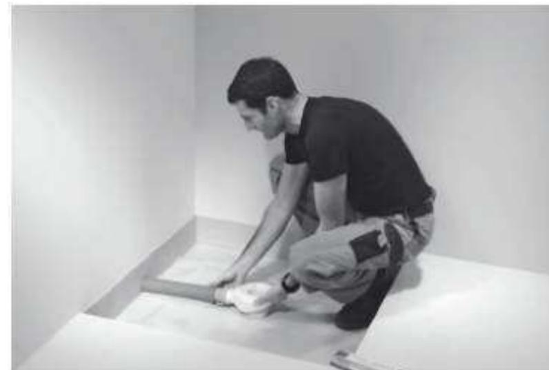
Positionnez le siphon au centre de la réservation et raccordez-le selon les règles de l'art, à la conduite d'évacuation DN 50 prévue.
