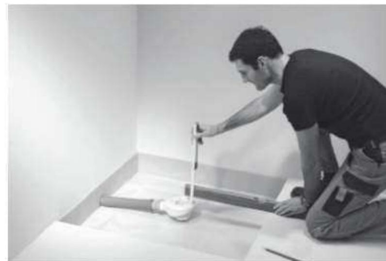
La distance nécessaire entre le niveau de la chape et le bord supérieur du siphon dépend des dimensions du receveur.
