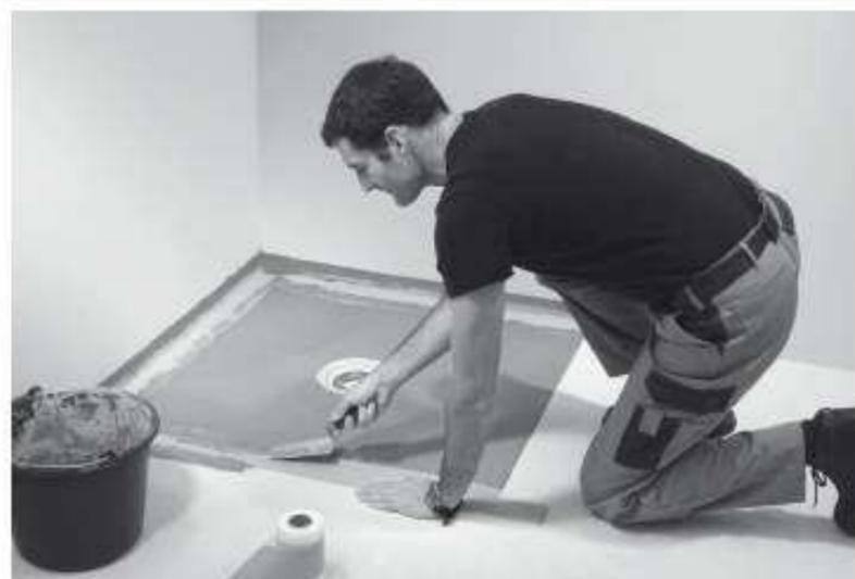
Traitez les raccords aux cloisons et au sol avec une bande d'étanchéité et un mortier-colle (colle à carrelage flexible type C2) afin d'éviter toute infiltration d'eau.
