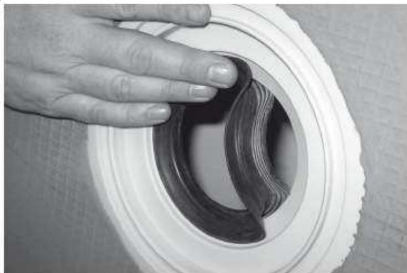
Placez ensuite le joint d'étanchéité dans la gorge du cadre du receveur. La lèvre la plus fine doit être placée sur la partie supérieure de la bride plastique et la lèvre la plus épaisse sur la partie inférieure.
