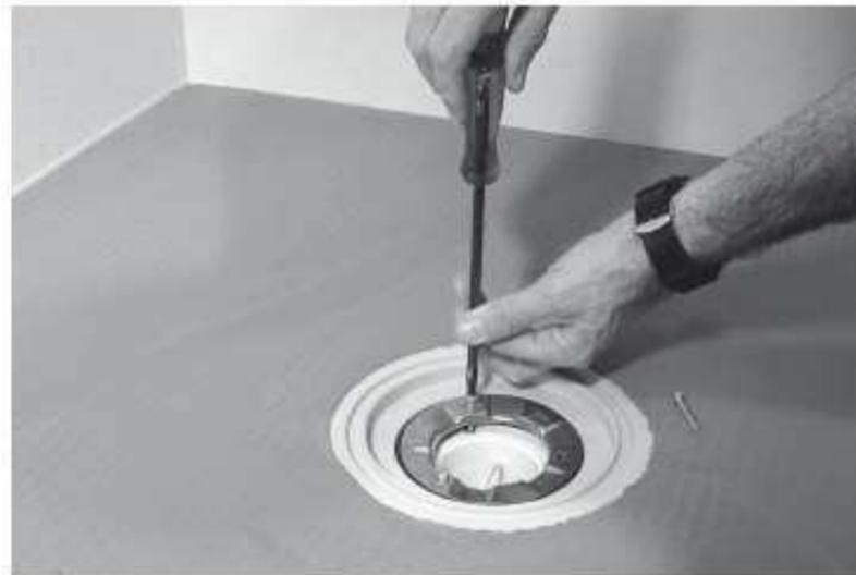
L'anneau de serrage métallique doit ensuite être fixé sur le receveur à l'aide des trois vis.
