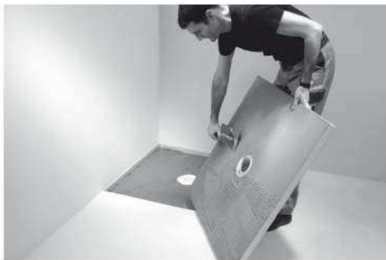
Une fois que le mortier de remplissage est sec, encollez entièrement la sous-face du receveur avec un mortier-colle adapté (colle à carrelage flexible type C2) en une couche régulière et une épaisseur suffisante afin de respecter le niveau final.
